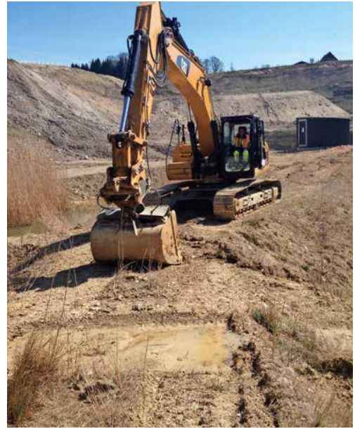
Mit dem Bagger werden Gewässer gebaut.
